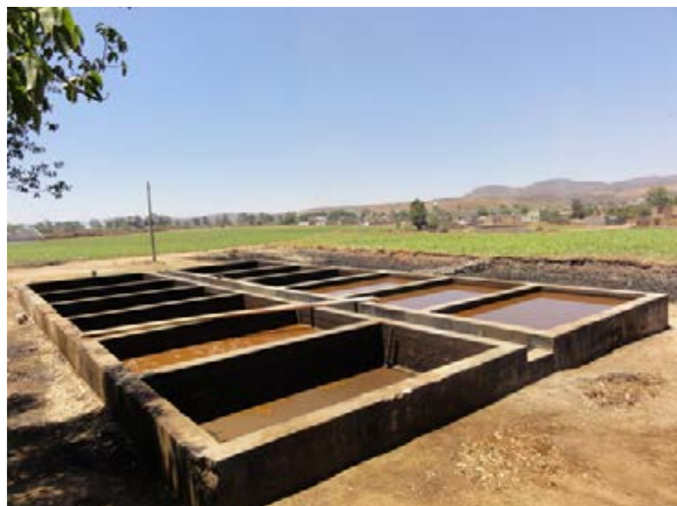
Figura 6. Separación de sólidos sedimentables por decantación.
